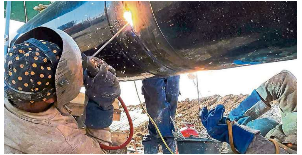
Rohre schweißen will gelernt sein.
