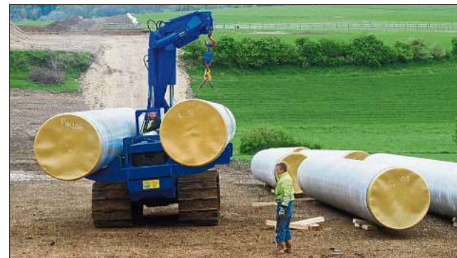
Trommler Rohrleitungsbau GmbH arbeitet an der Sicherstellung der Fernwärmeversorgung in Baden-Württemberg.
